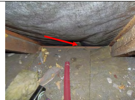
Undertagsfag set mod skråvæg - ventilation synes ok
