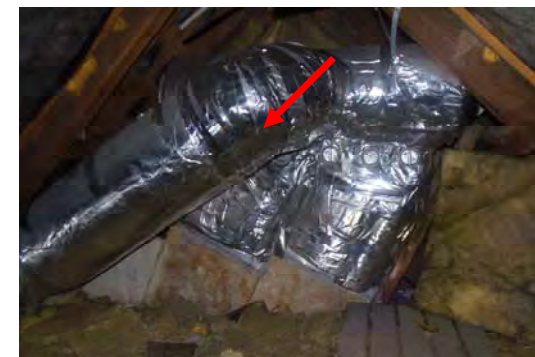
Eksempel på mekanisk ventilation tilsluttet kanaler
