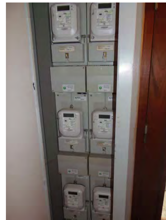
Eksempel på målertavle i trapperum
