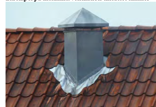
Eksempel på afkastrør op gennem tagflade
