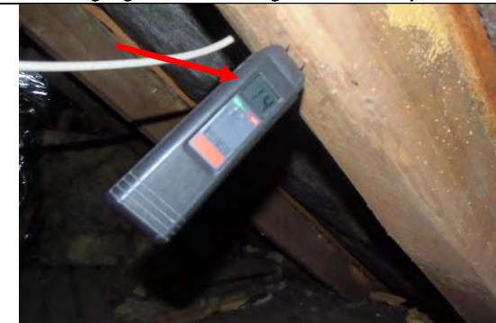
Undertagsfag set mod skråvæg - ventilation synes ok
