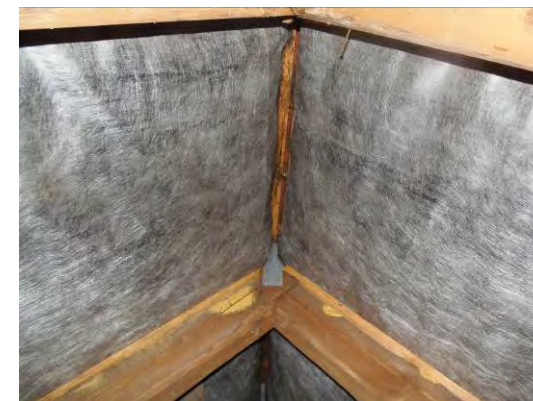
Ventileret rygningsskonstruktion med topplanke
